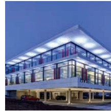
Schnepf Energietechnik Nagold (Germany)
